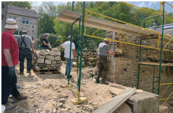
Un mur qui doit bien se tenir après l'intervention de l'équipe des maçons
