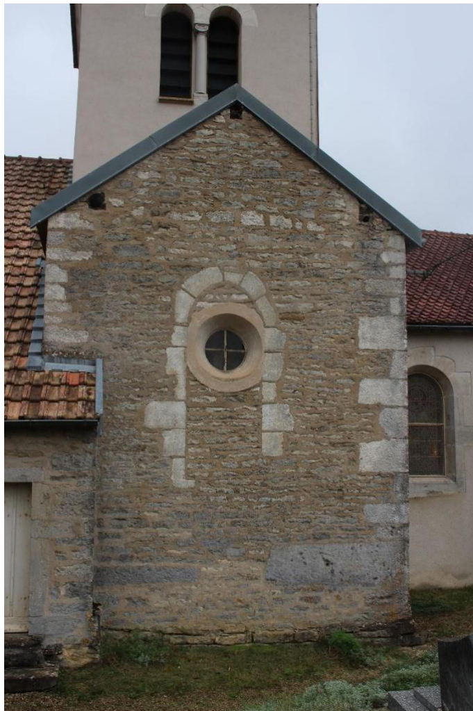
Figure 24 Mur nord de la chapelle de la Vierge
