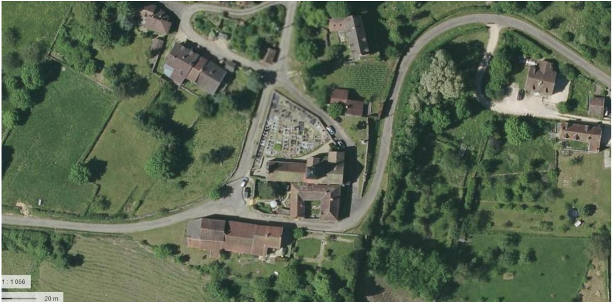
Figure 1 Vue de l'église ©Géoportail
