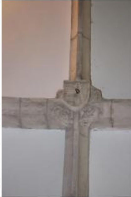
Figure 13 Clef de voûte de la Chapelle sainte-Anne
